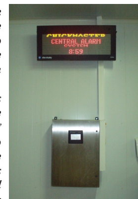
El sistema de alarma central Chick Master de 'alta visibilidad' para la planta de incubación.
