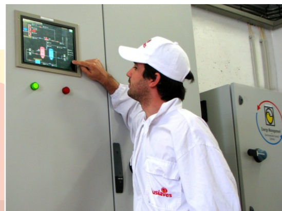
Operando el sistema Chick Master de Recuperación de Calor y Manejo de Energía.
